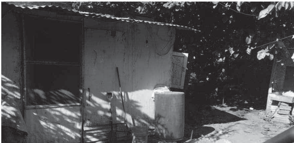
Imagen no. 25 Vivienda de tipo precaria en el municipio de Puente Nacional Ver.
